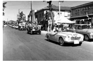
国道28号道路改良工事完成(S39年青木交差点付近)
