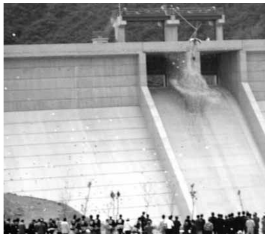
諭鶴羽ダム完成(S49年)
