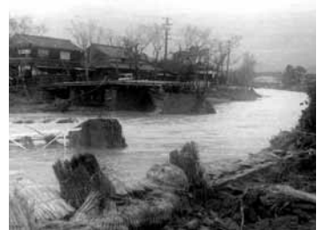
台風豪雨により流出した掃守中所橋(S40年)
