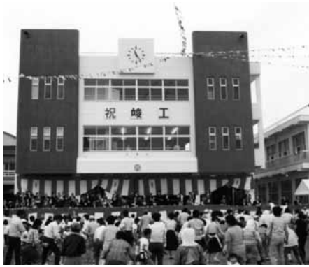
榎列小学校新校舎完成 (S56年)
