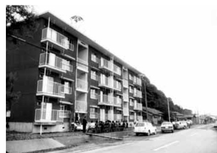
町営住宅志知団地完成(S50年)
